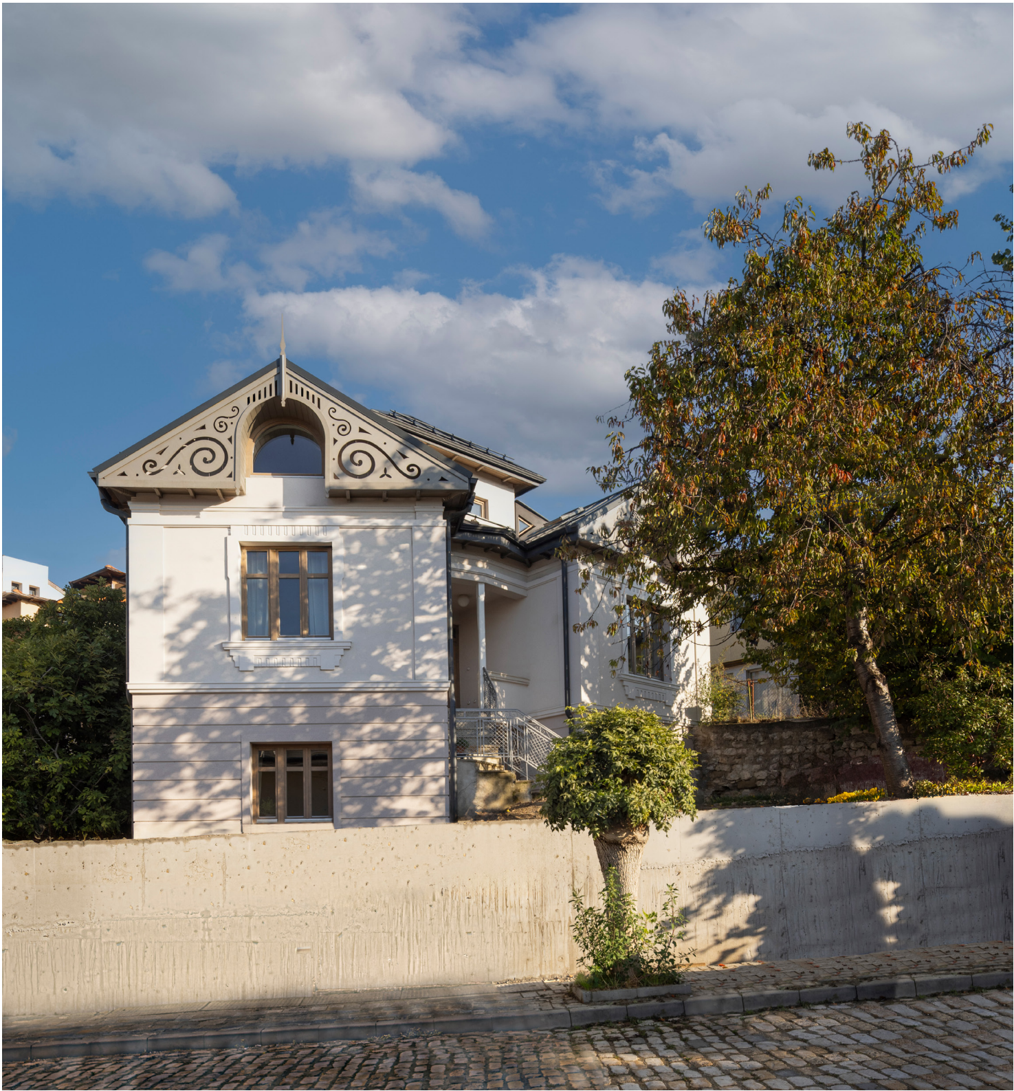
Ограда юг - реконструкция в процес
